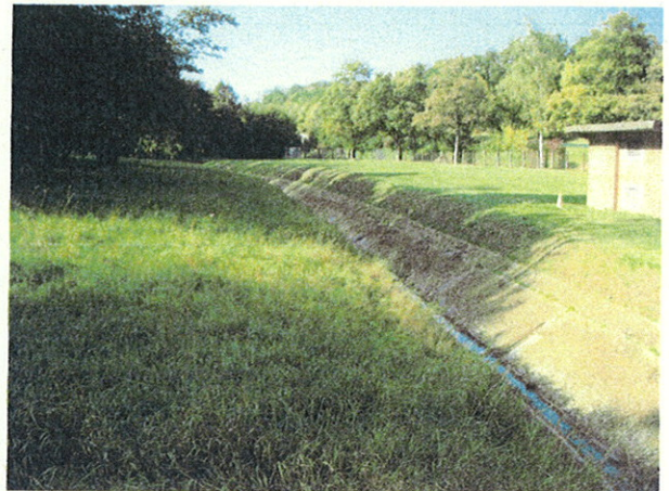
Abb. 7: Betoniertes Bett des Holz- oder Gänsbachs ohne Strukturelemente
