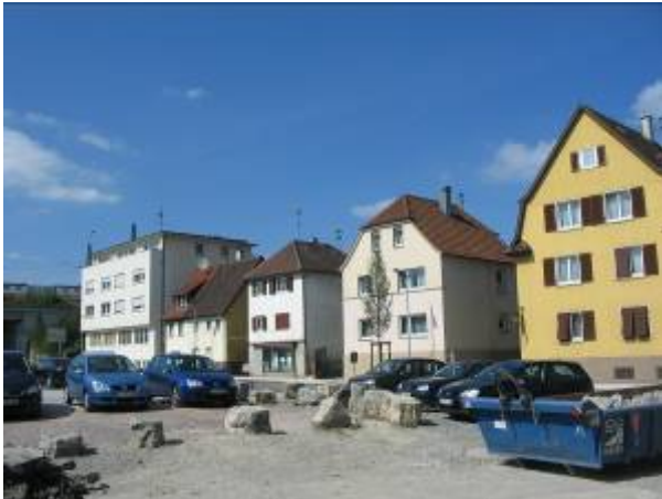
Foto 1: Holzgrundstraße 4-12, Eckhaus Christophstraße 1 Anblick von Süden
