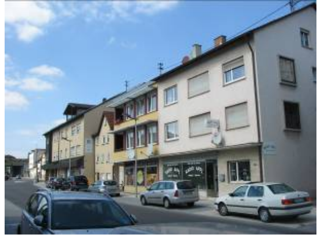
Foto 8: Jakobstraße 26-32 Blick von Südosten
