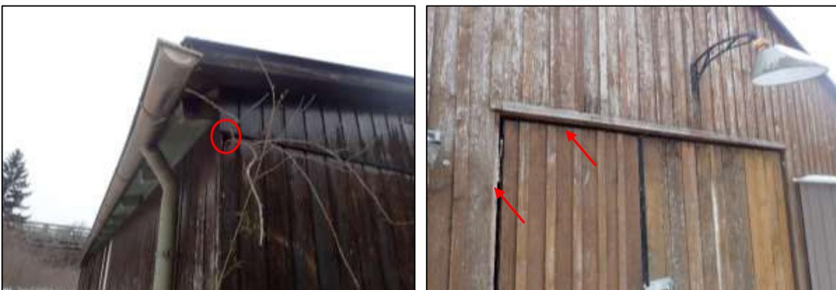
Abbildung 7: Spalten und Öffnungen an Gebäudefassaden (roter Kreis und rote Pfeile) bieten Kleinvögeln und Fledermäusen Zugang zum Gebäudeinneren.
