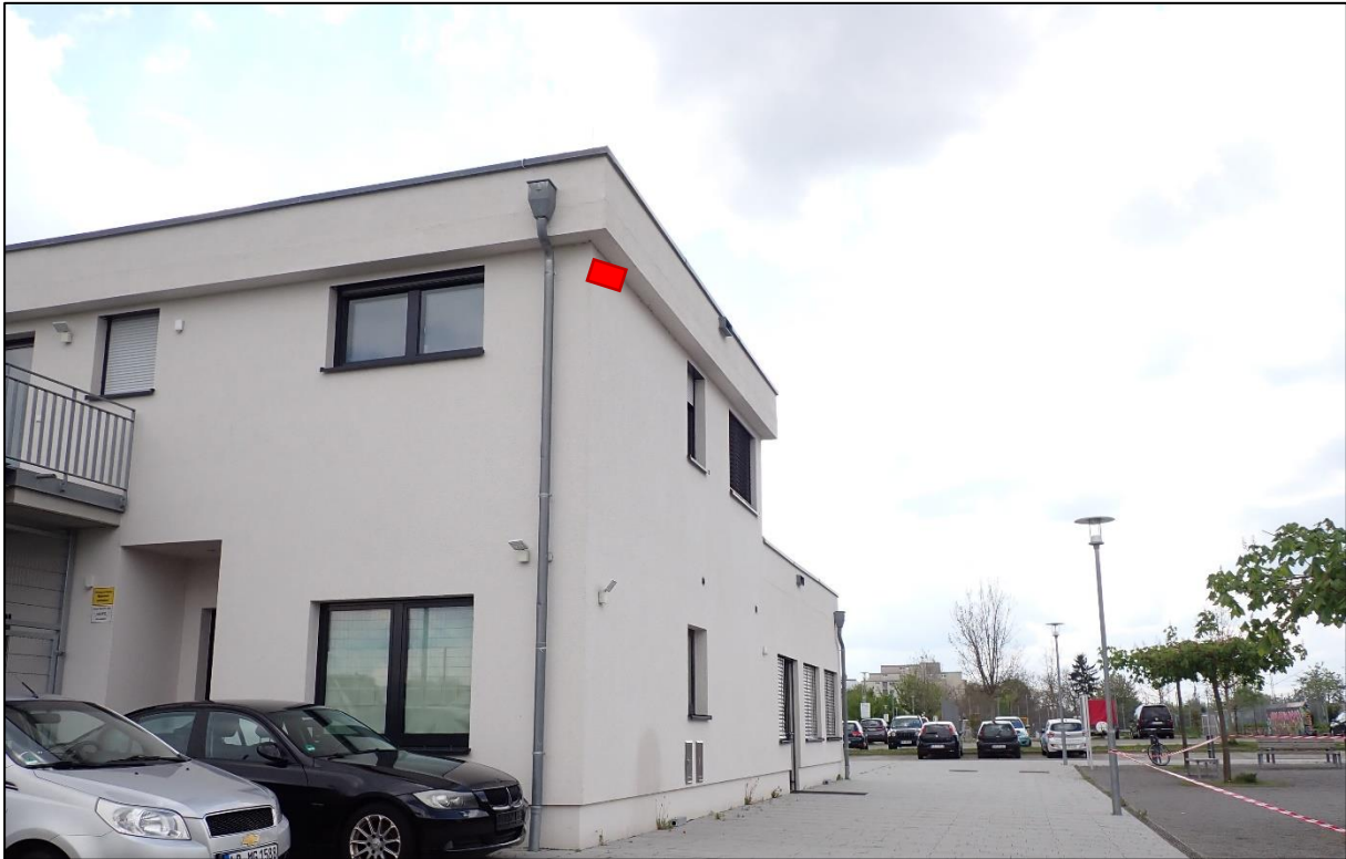
Abbildung 6: Möglicher Hangplatz einer Nisthilfe für Nischenbrüter (rotes Rechteck) an der Westfassade der Jahnhalle.
