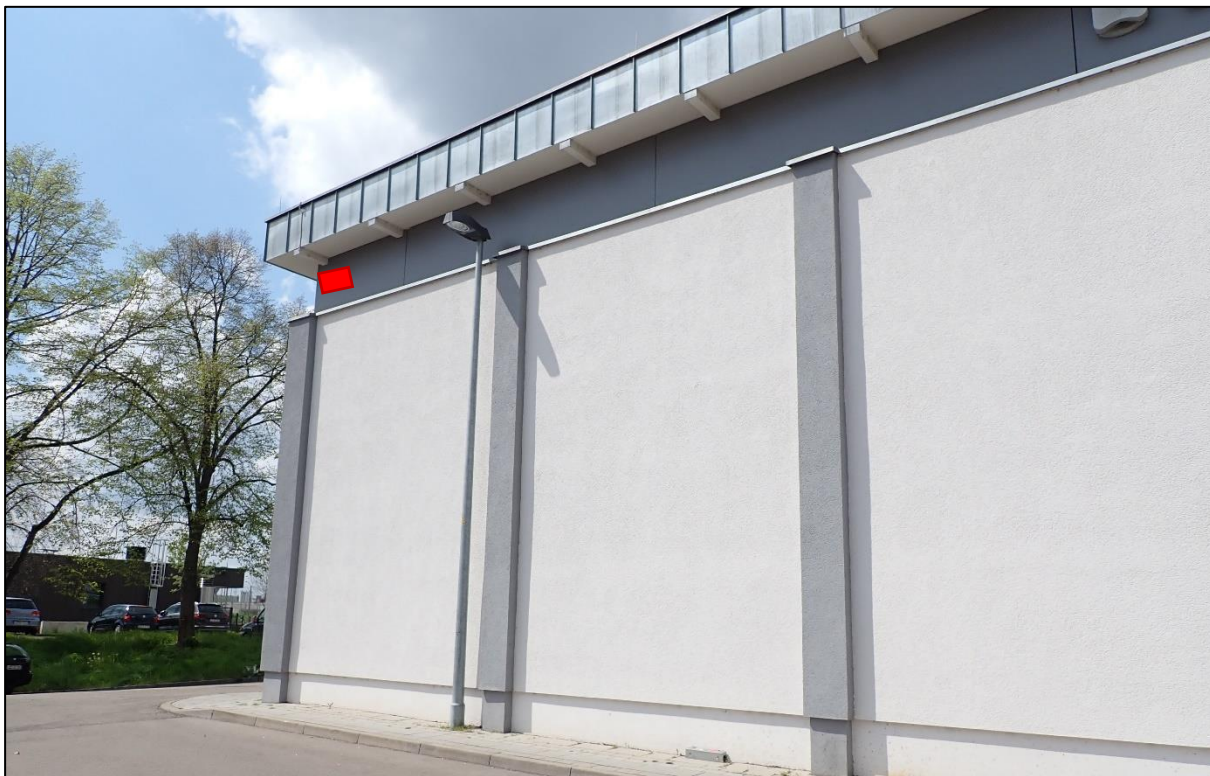
Abbildung 4: Möglicher Hangplatz einer Nisthilfe für Nischenbrüter (rotes Rechteck) an der Ostfassade der Jahnhalle.
