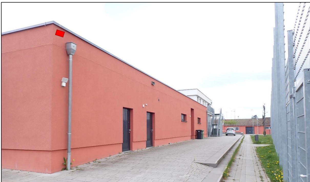
Abbildung 5: Möglicher Hangplatz einer Nisthilfe für Nischenbrüter (rotes Rechteck) an der Nordfassade der Jahnhalle.
