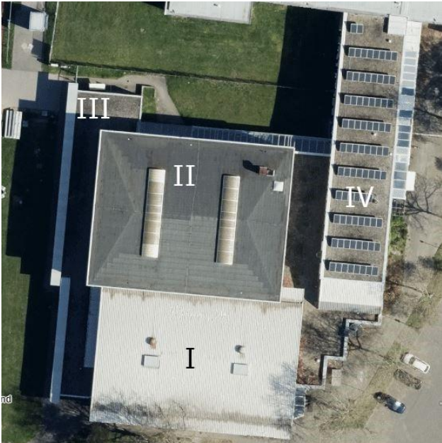
Abbildung 2: Dachflächen Sporthalle Pattonville
