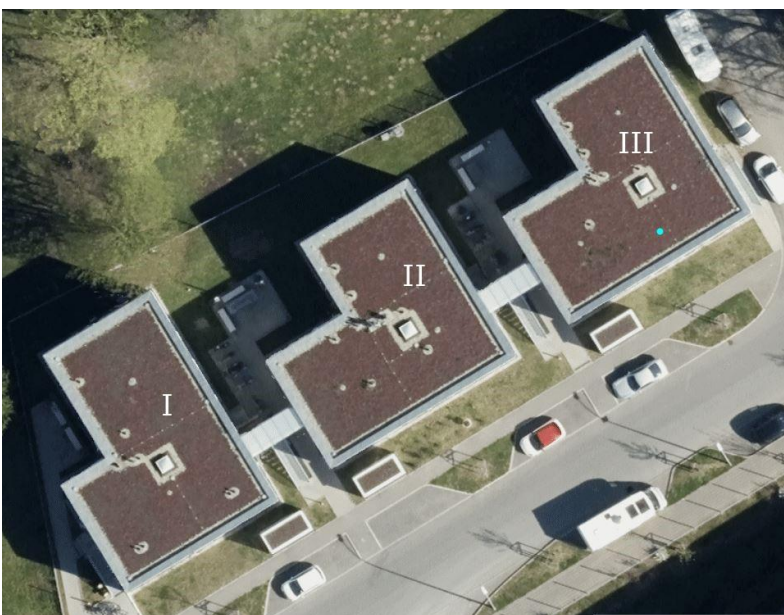
Abbildung 7: Dachflächen Wohngebäude Moldengraben
