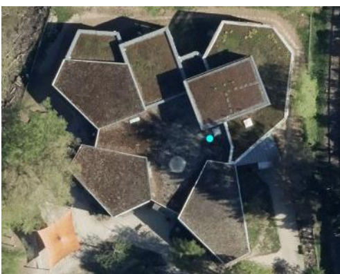
Abbildung 16: Dachflächen Kindergarten Bolzstraße
