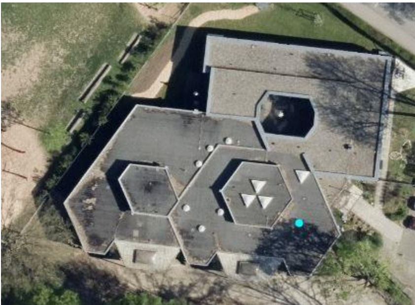
Abbildung 15: Dachflächen Kindergarten Daimlerstraße
