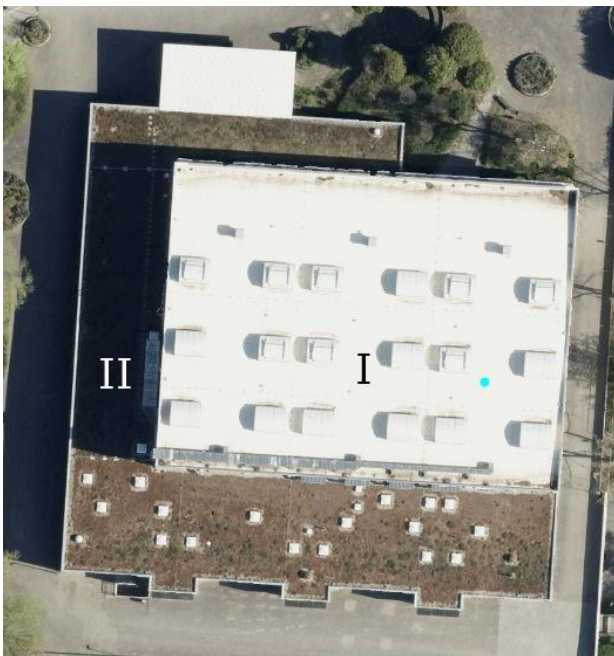
Abbildung 19: Dachflächen Sporthalle Ost
