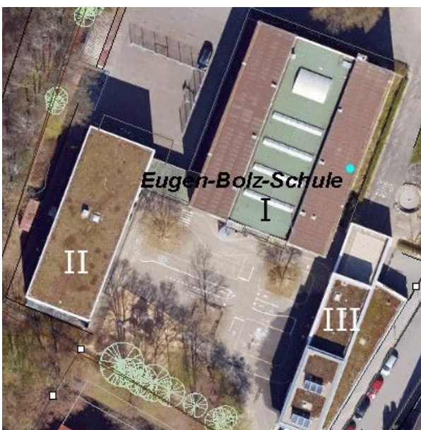
Abbildung 11: Dachflächen der Eugen-Bolz-Schule
